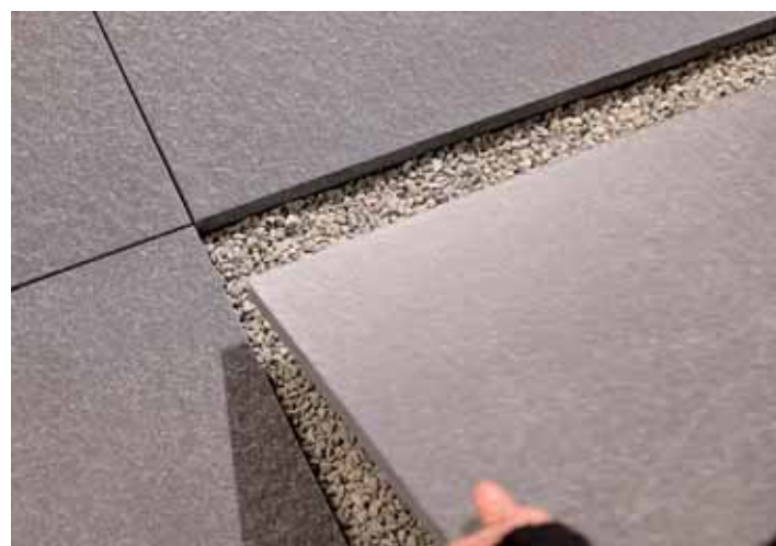
Posa diretta su ghiaia Dry installation onto gravel
